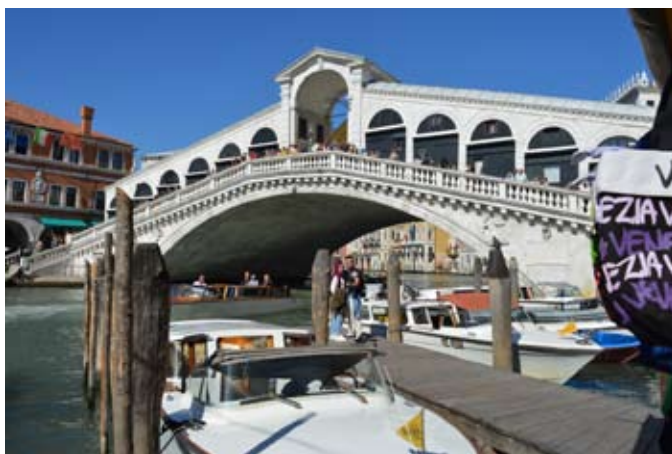
Die Rialto-Brücke in Venedig (Foto: Dr. Achim Jaeger)
