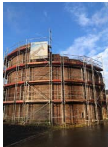
Aktuelle Restaurationsarbeiten am Dicken Turm (Foto: Dr. Achim Jaeger)
