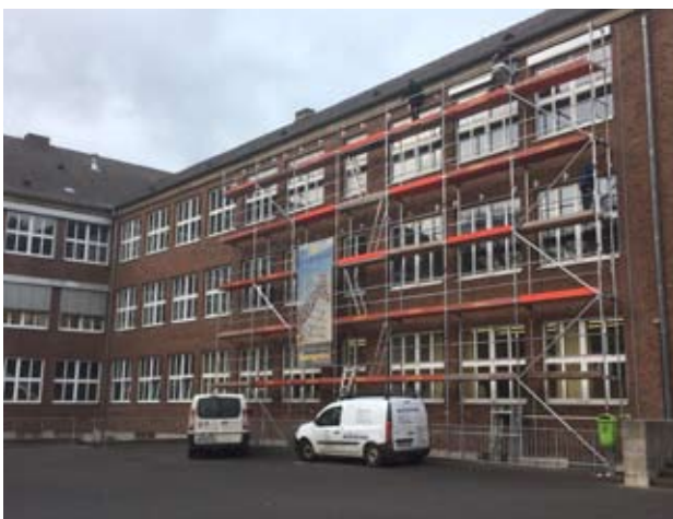
Anbringung der Jalousien am Hauptgebäude im November 2020 (Foto: Dr. Achim Jaeger)
